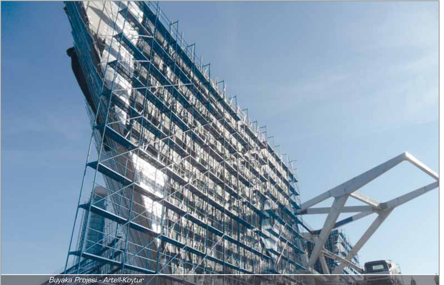
Yalçinkaya Sitesi Projesi - Karyap Yalıtım
